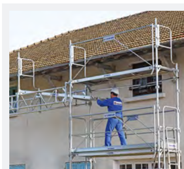
Chariot roulant modulable (adaptation à la largeur de travée souhaitée)
