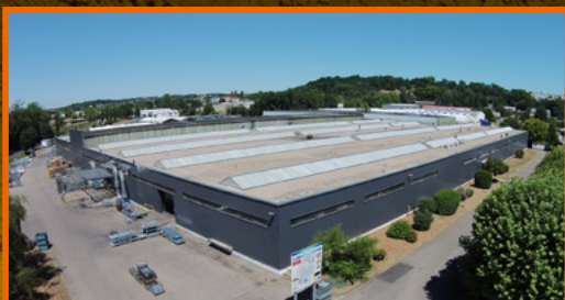
Site de production de Trévoux (01)
