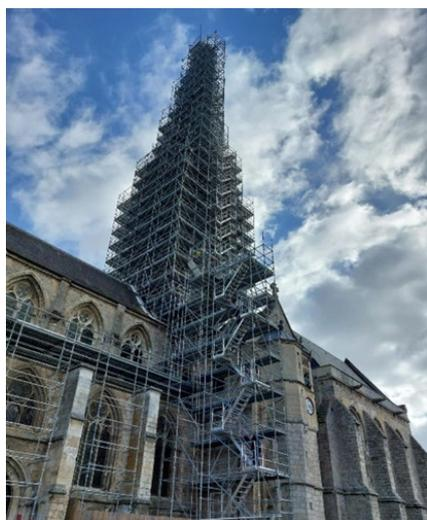
La structure a été imaginée et conçue pour faciliter l'accès aux divers corps de métier et se compose :
