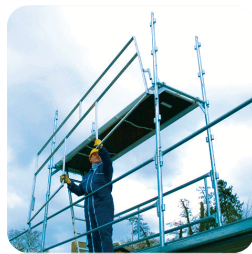
Montage en sécurité
